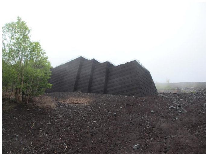
落石防止の堰堤(その先の山斜面は雲で見えず)
