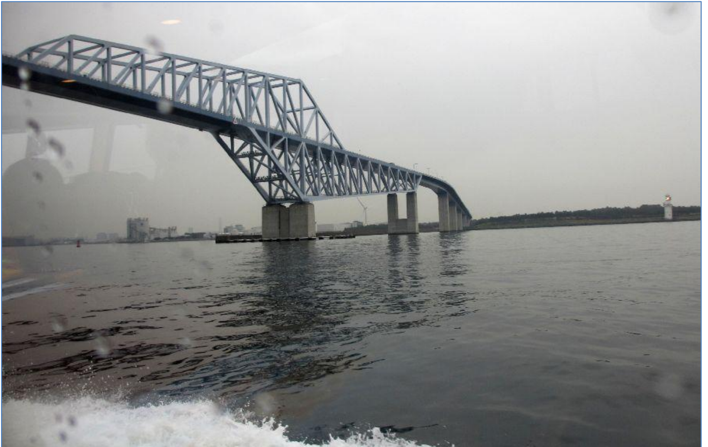
東京国際空港（羽田空港）を右先遠くに見た後、廃棄物処分場を左周して東京 ゲートブリッジをくぐる
