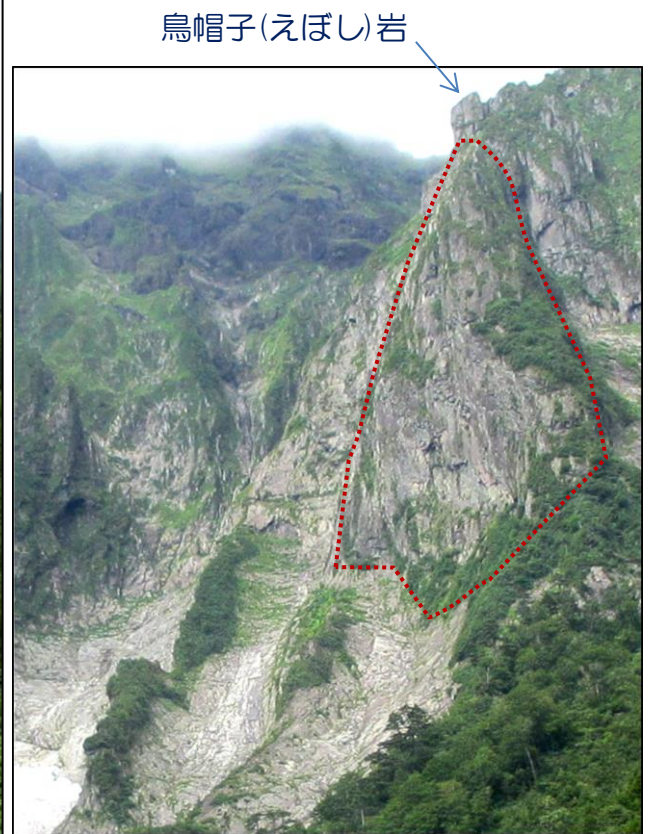
「衝立岩（高度差約 300m）」の 部分拡大写真
